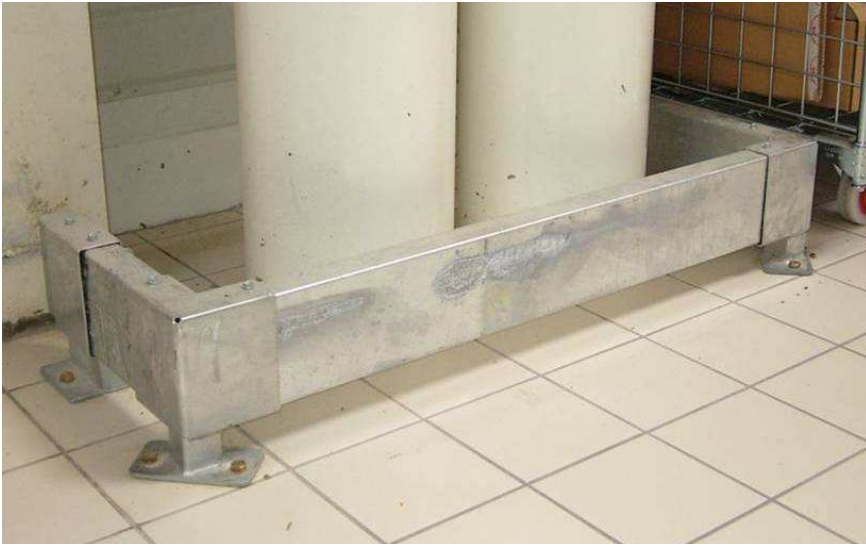
Protection des poteaux
